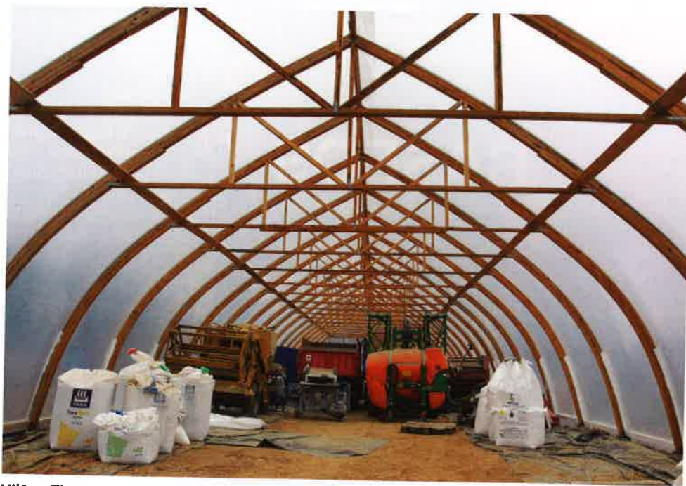
Viļānu Zinātnes centrā uzbūvēta vienkārša, dažādām vajadzībām izmantojama siltumnica.
