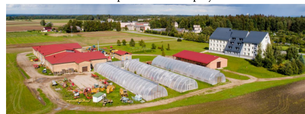
AREI Priekulī Pētniecības centrs Zinātnes ielā 2 Priekulī.
